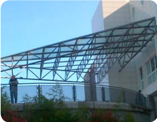
Montaje de Estructura Tubular. Hospital Cabueñes
